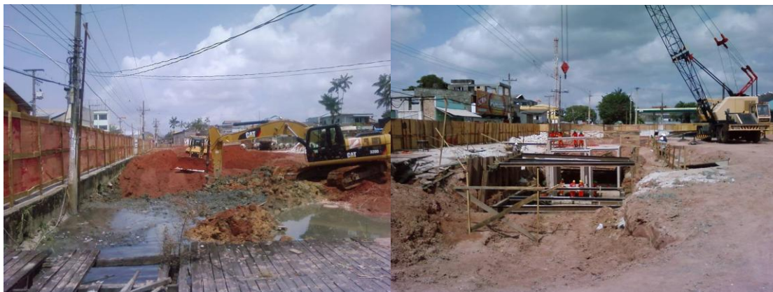
Figura 7. à esquerda canal da Bernardo Sayão sendo dragado, drenado e aterrado. Fonte: o autor (novembro/2012) e Figura 8. mostra a instalação das galerias pluviais em uma área da sub-bacia 4 no canal da Bernardo Sayão. Fonte: Adriane Azevedo (novembro/2012).
