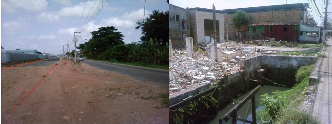
Figura 9. à esquerda tracejado esboçando a continuação da duplicação da Av. Bernardo Sayão. Fonte: o autor (novembro/2012) e Figura 10. tem-se o processo de demolição das residências localizadas as margens do canal da Bernardo Sayão. Fonte: o autor (novembro/2012).
