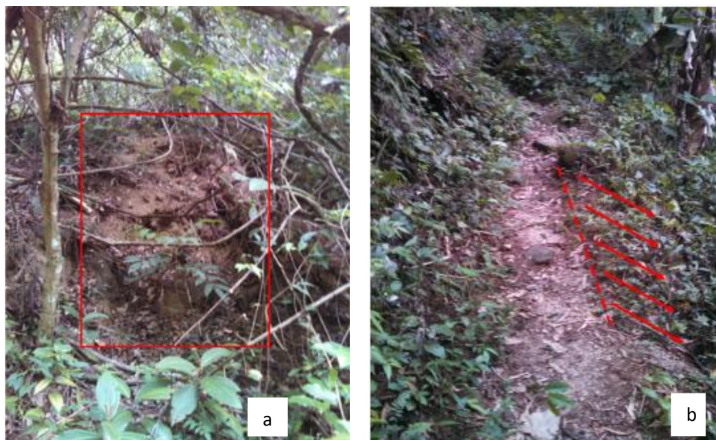
Figura 7. Movimento de massa no talude superior da trilha (destacado em vermelho) (a); perda de borda crítica (destaque em vermelho) no terceiro trecho da trilha Sahy-Rubião (b). Fotos: Fotos: Autor (2015).
