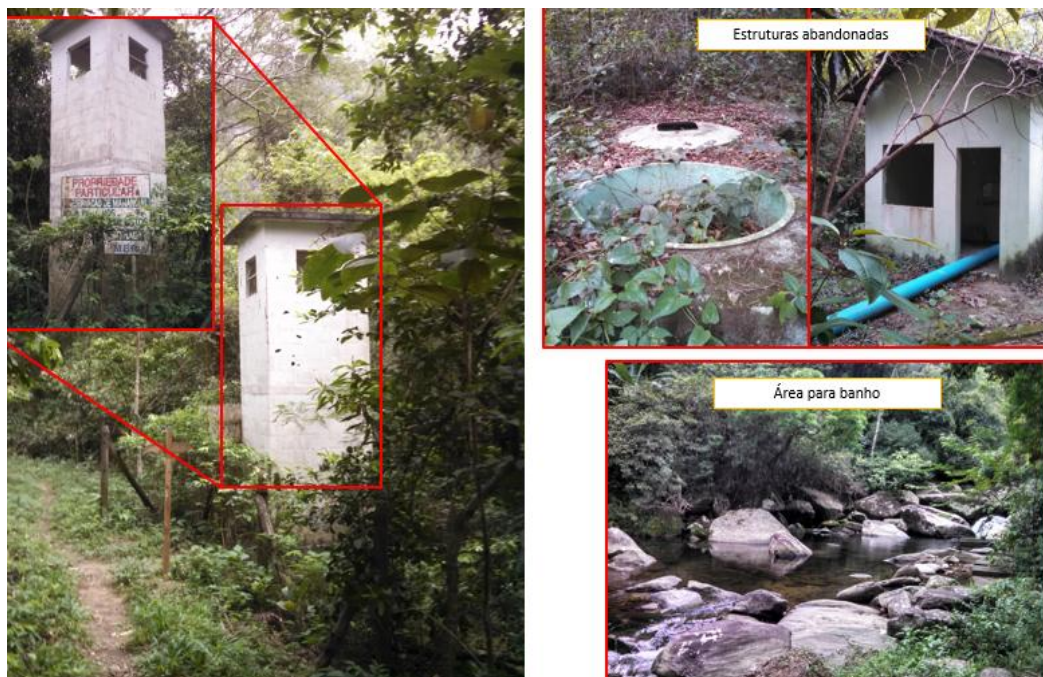
Figura 9. Torre que pode ser utilizada para fiscalização (a); estruturas de manutenção de captação de água abandonadas (b); poço dos Escravos no terceiro trecho da trilha Sahy-Rubião (c), onde há uma. Fotos: Autor (2015).
