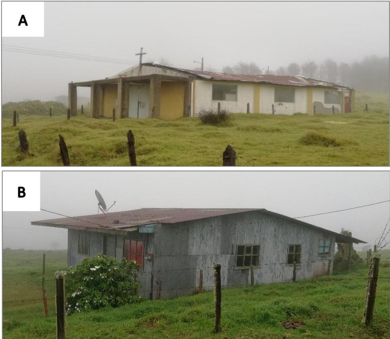
**Figura 4.** A). Iglesia ubicada en el sector de finca La Central (sector de afectación fuerte por lluvia ácida), la cual presenta signos importantes de corrosión y deterioro asociado a la lluvia ácida y gases. B). Vivienda ubicada entre La Pastora y La Central con notables signos de corrosión en el techo por la lluvia ácida. Fuente: Propia, 2017.
