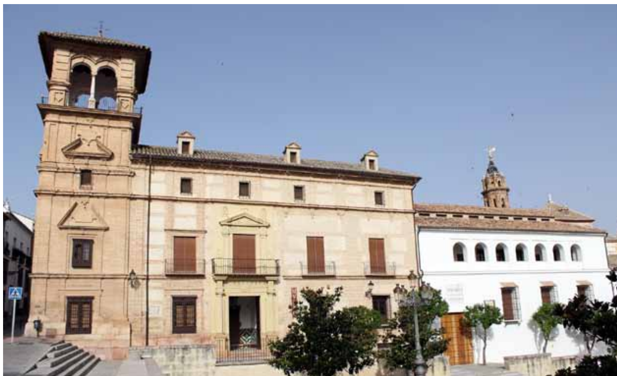
Fig. 1. Fachada del palacio de Nájera sede del MVCA. Foto: J. M. Ortiz. Archivo fotográfico MVCA.
