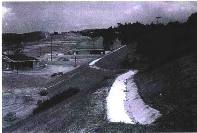
Figure 4.2 Concrete-paved Ditch (Coduto, 1999)
