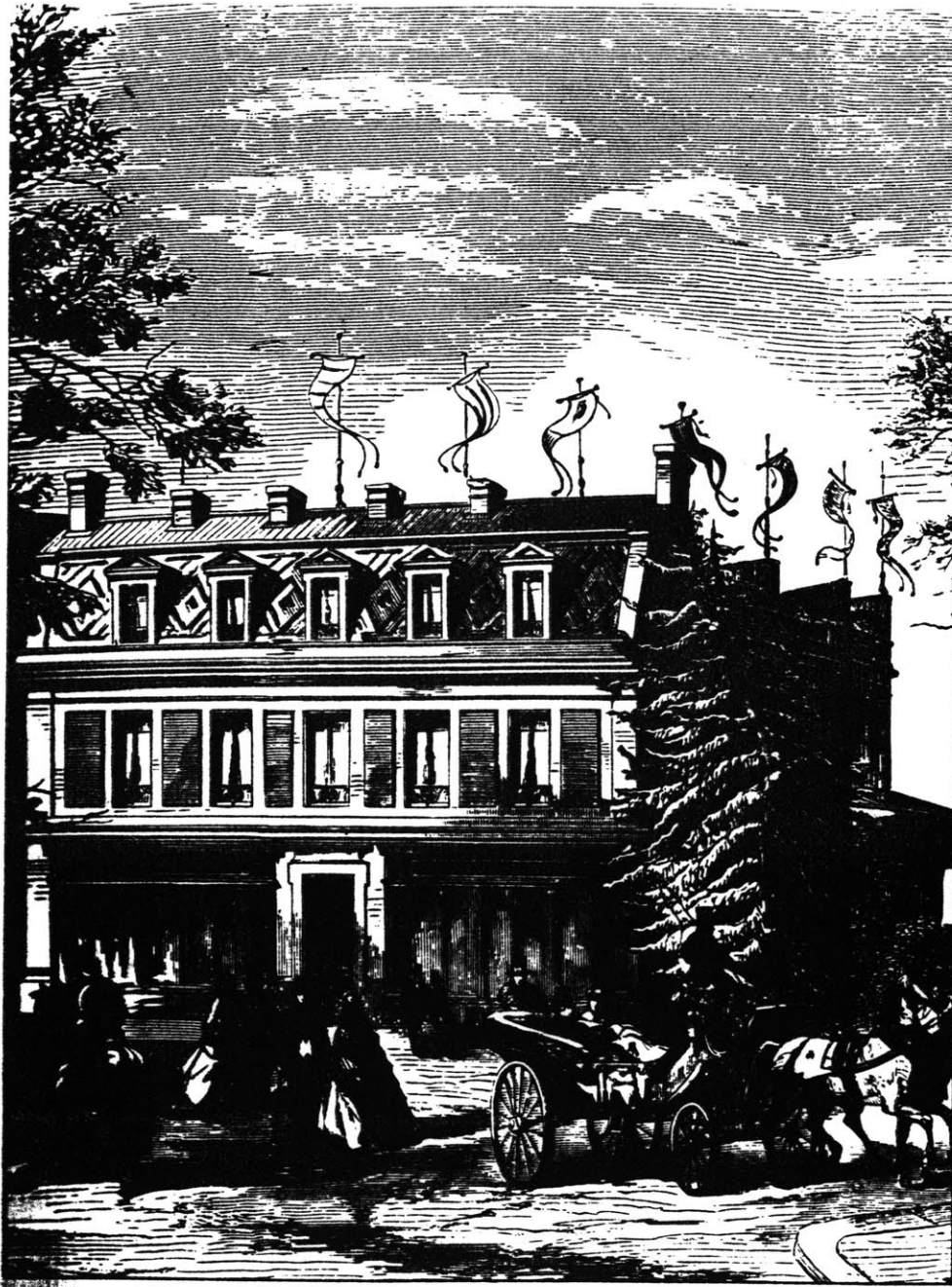
MAISON OUVRIERE CONSTRUITE DANS LE PARC, AUX FRAIS ET SUR LES DESSINS DE L'EMPEREUR
