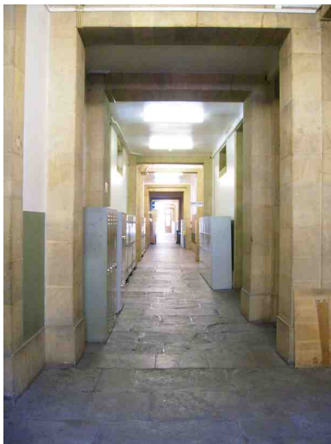
Photo 12 - couloir de l'entrée est du bâtiment
