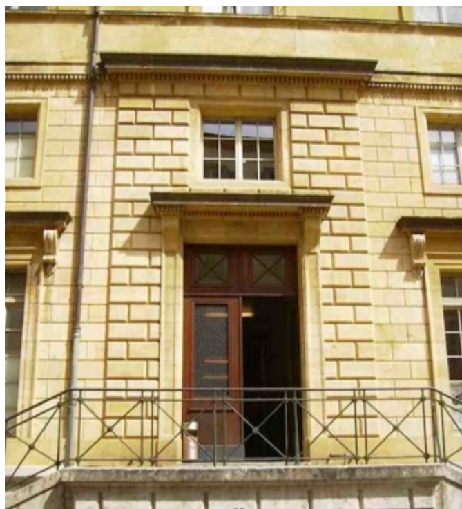
Photo 5 - entrée ouest du bâtiment
