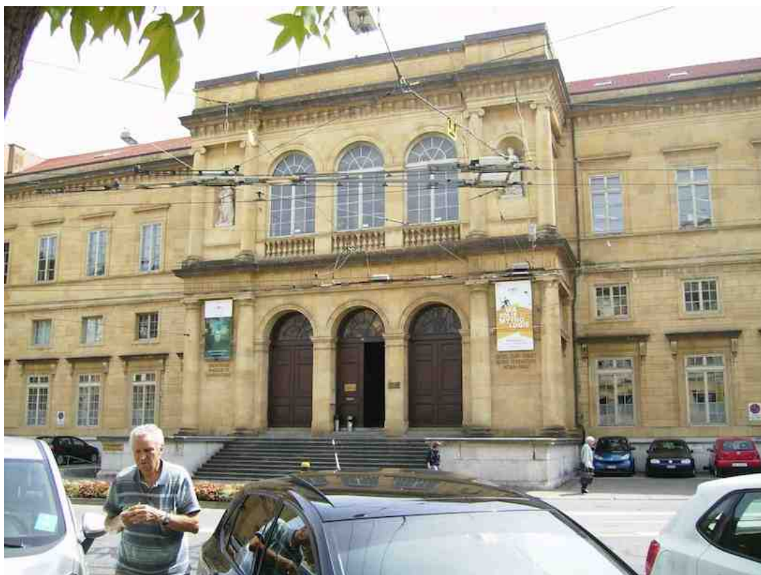
Photo 3 - façade nord et entrée de la bibliothèque
