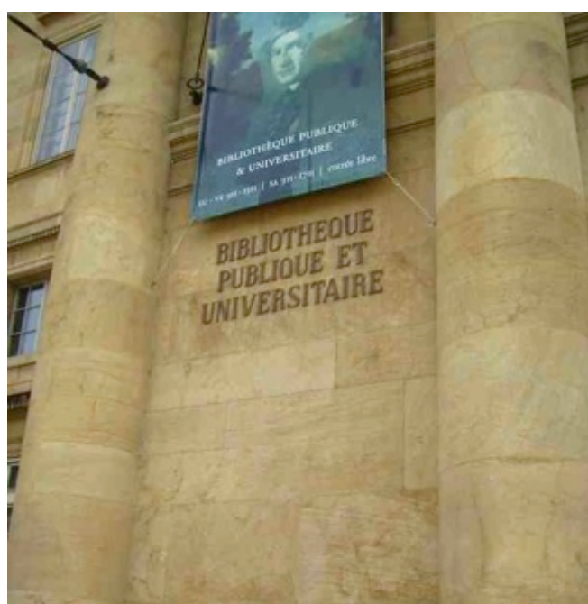
Photo 4 - détail de la signalétique de la façade nord
