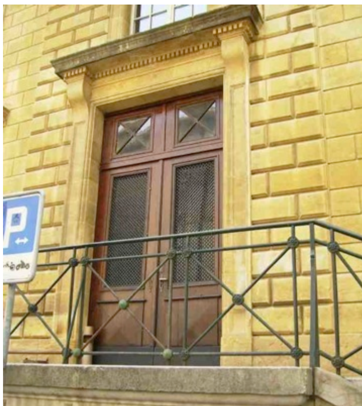
Photo 6 – entrée est du bâtiment
