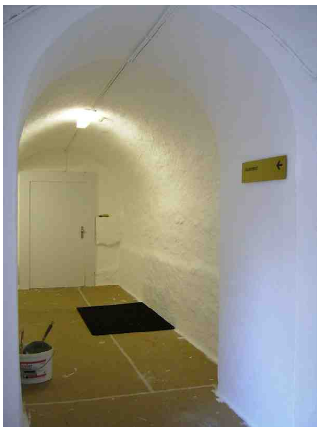
Photo 8 - couloir menant à l'ascenseur, en rénovation
