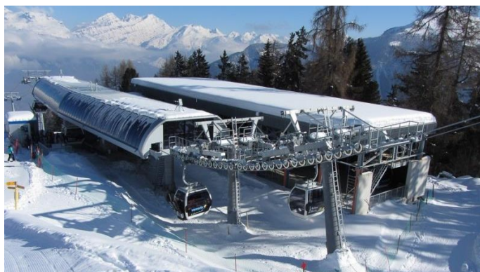
Figure 11 Installation intermédiaire - Sigeroulaz
