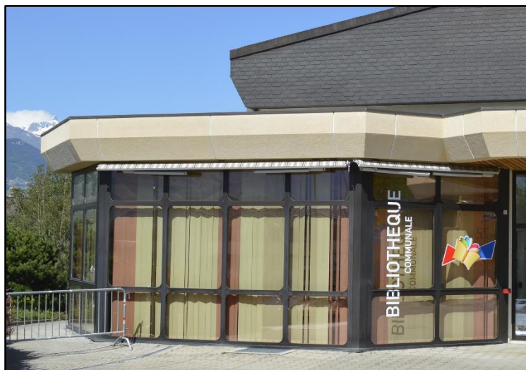
Figure 23- Bibliothèque du Centre sportif de Combremont
