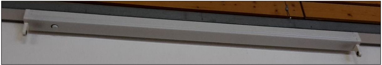
Figure 9- Exemple de support pour tube néon de 36 W
