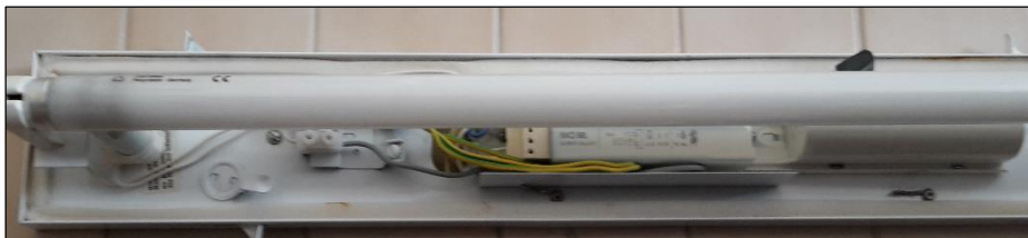
Figure 10- Exemple de support pour tube néon de 18 W
