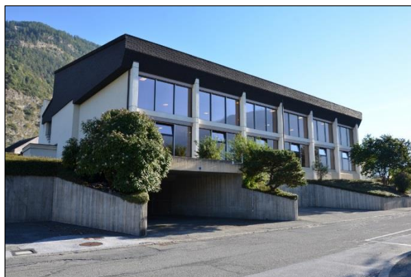
Figure 5- Centre sportif de Combremont
