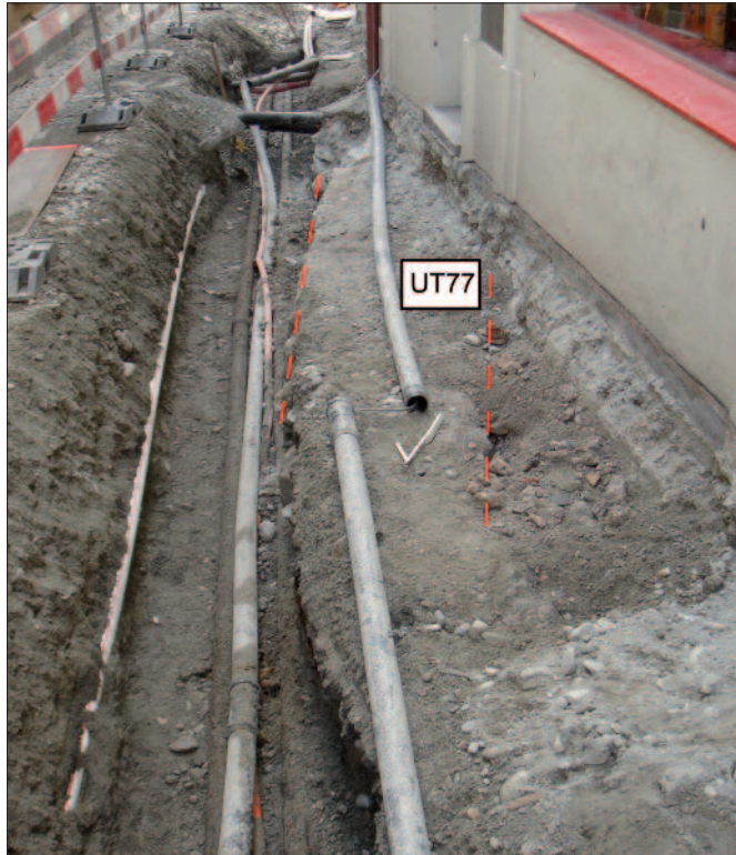
Fig. 39 – Sion, rue de Supersaxo, vue depuis le nord, fouilles 2010. A droite de la tranchée, l'ancienne façade arasée (UT77) conservée sur une longueur de 2 mètres.
