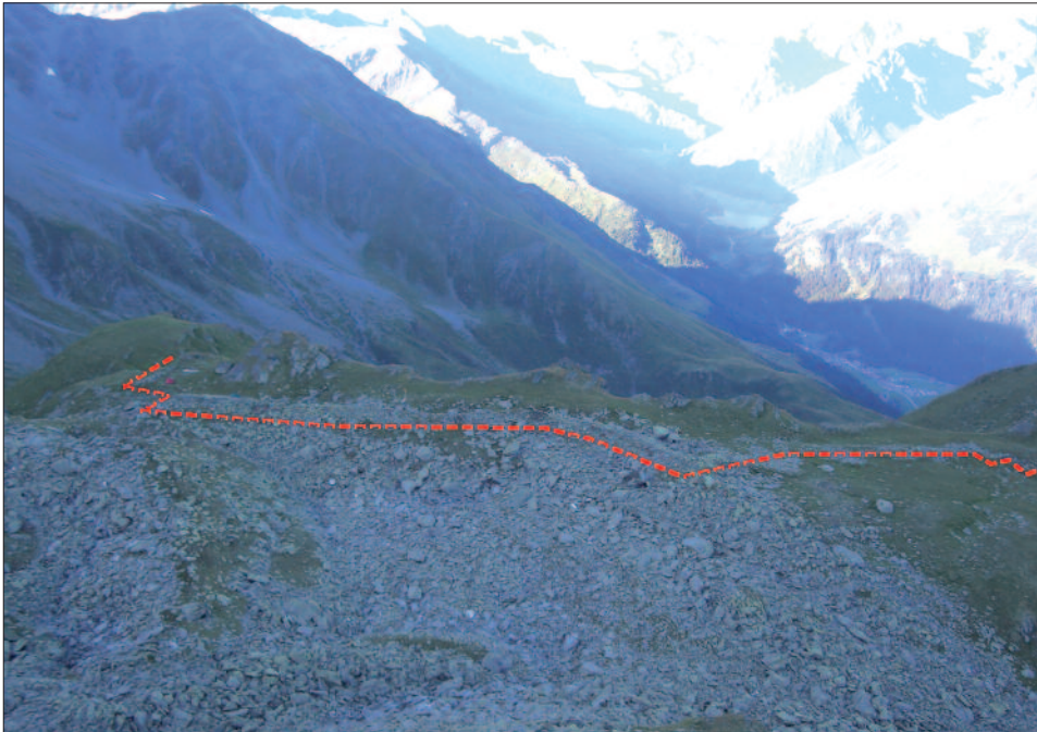
Fig. 8 – Liddes, Creux de Boveire, «Mur (dit) d'Hannibal», vue générale du site en direction du sud, prise depuis un contrefort de la Pointe de Boveire. Limites extérieures du mur d'enceinte marquée en traits-tirés rouges.
