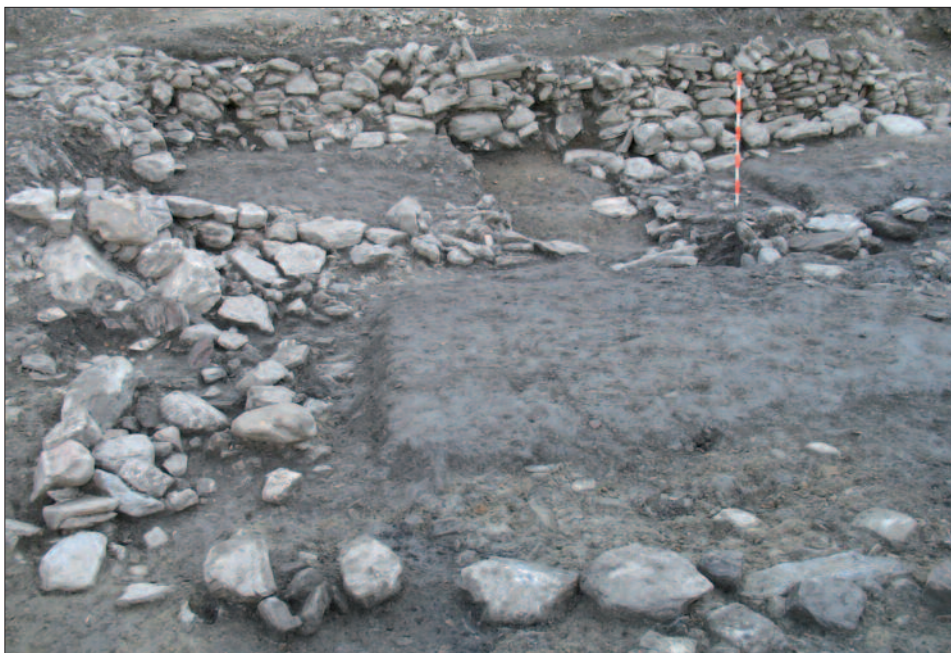
Fig. 19. – Oberstalden, chantier Furrer. Le bâtiment médiéval (entre 600 et 800) vu vers le nord-est. A l'arrière-plan, le mur amont de l'édifice est construit à sec et comprend des poteaux verticaux intégrés dans le mur.
