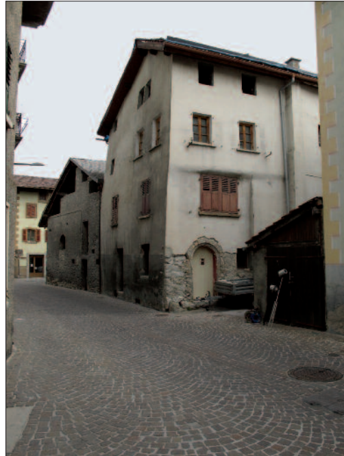
Fig. 3. – Maison villageoise de Bramois. Le solivage du plafond des caves et du rez-de-chaussée date de 1341.
