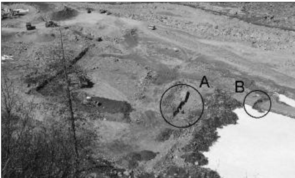
Fig. 5 – Bourg-Saint-Pierre, Barrage des Toules. Vue générale du chantier. Les cercles indiquent la position respective des deux tranchées ouvertes à travers la Cantine de Proz (A) et la route du XIX e siècle (B).
