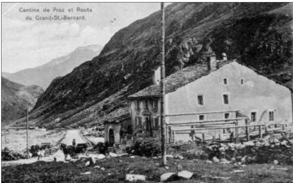
Fig. 8 – Bourg-Saint-Pierre, Barrage des Toules. La Cantine de Proz vers la fin du XIX e siècle, avec la route achevée en 1893 et la ligne télégraphique, vue vers l'aval. La calèche est stationnée plus ou moins à l'endroit où nous avons effectué le profil à travers la chaussée. Carte postale, Dorsaz, Photo, Martigny, no. éditeur 115.
