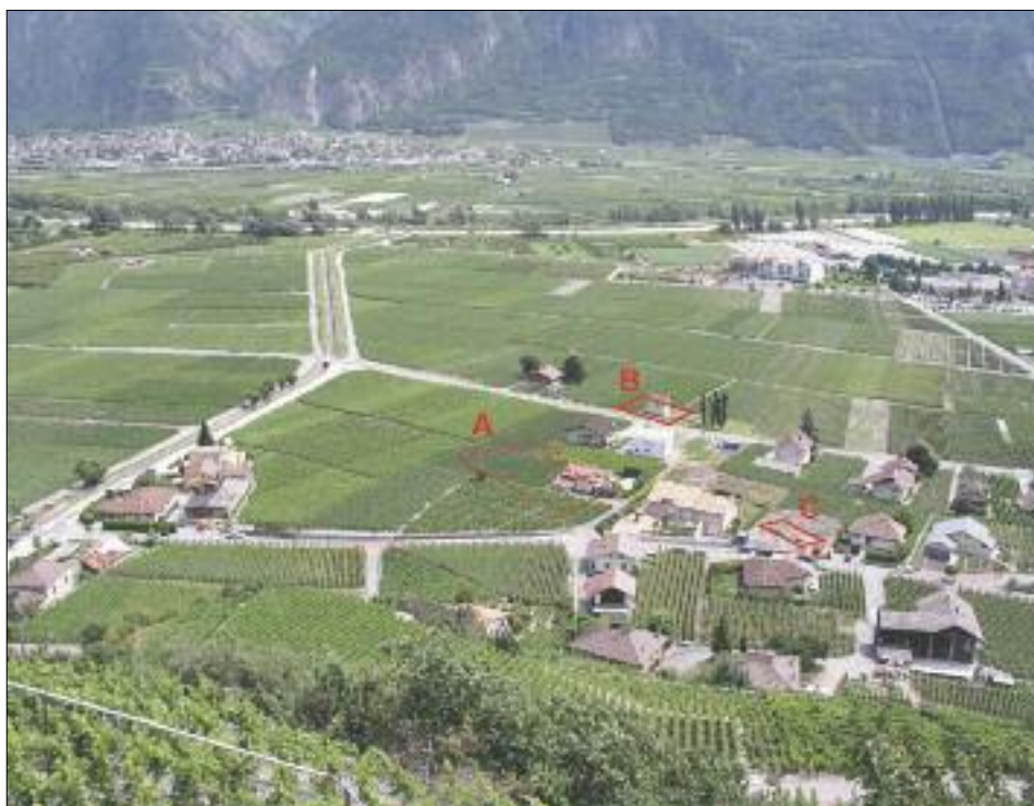
Fig. 20 – Saillon/Les Proz. Le secteur des Proz de la Grange avec l'emplacement des différents bâtiments de la villa. A (1945), B (1974-77 et 2006), C (2008). En arrière plan, le village de Riddes. Vue depuis le nord.
