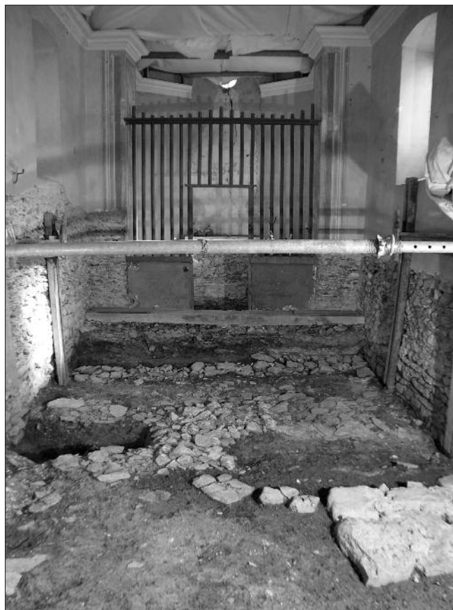
Fig. 12 – Vue générale des vestiges apparus dans la nef, sous le sol de la chapelle baroque (vue vers le chœur). Un sondage jusqu'au substrat naturel a permis la découverte du cimetière.
