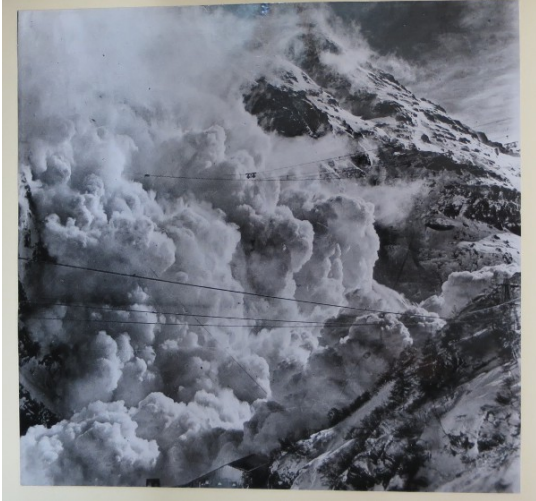
Barrage de Mauvoisin, ZSC-IM-033
