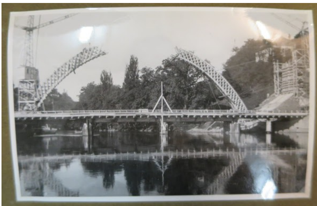
Pont-rail de la Jonction, ZSC-IM-008
