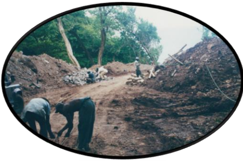
Abbildung 4: Jungle Bay Konstruktion
