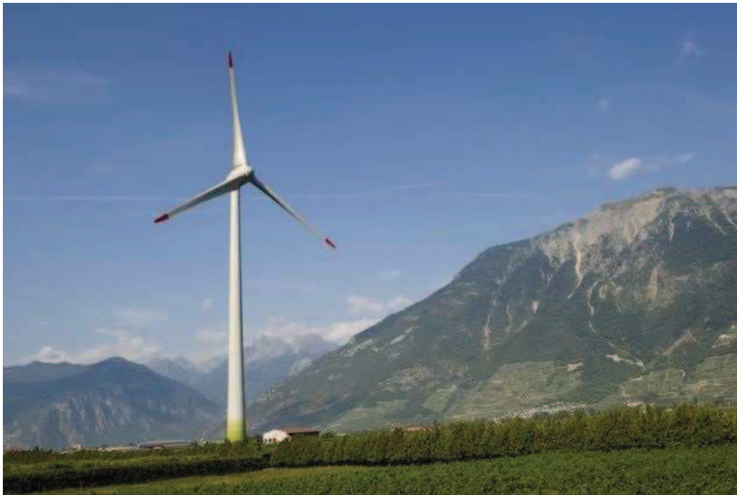
Figure 3: Eolienne de Charrat (Valais), 3MW
