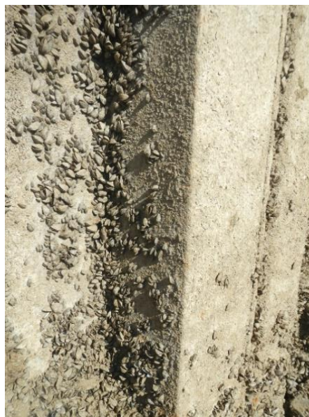
Figuur 3.6: Drooggevallen driehoeksmosselen en quaggamosselen in de Maas nabij Yvoir (België) na het openen van de sluizen voor onderhoudswerkzaamheden in 2012 (© Foto: Frank Collas).
