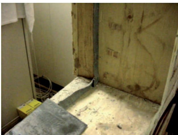
Figura 3: Blindaje de plomo en una ventana de una sala de RX
