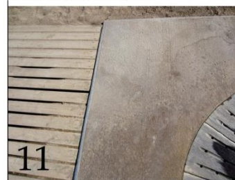
Ilustración 11: Vinculación de la pasarela con el suelo de las duchas, Playa de San Sebastián, Autora: Boryana Mihaylova
