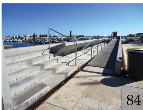
Ilustración 84: Solución del desnivel, Zona de Baños Forum, Autora: Boryana Mihaylova
