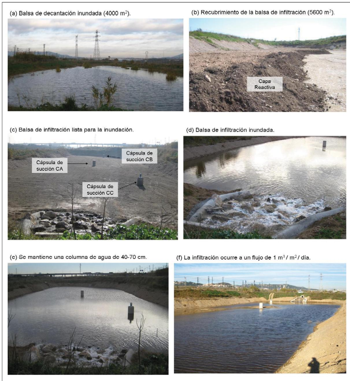
**Figura 4 - 3.** Fotografías de las balsas de decantación e infiltración durante el proceso de recarga artificial.
