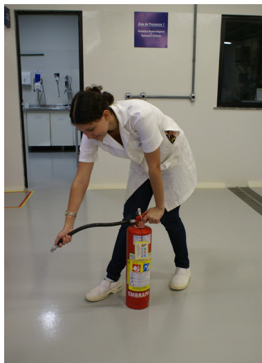
Figura 33. Utilização do extintor de Pó químico.
