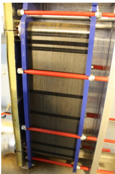
Figur B5-2 Varmveksler.
