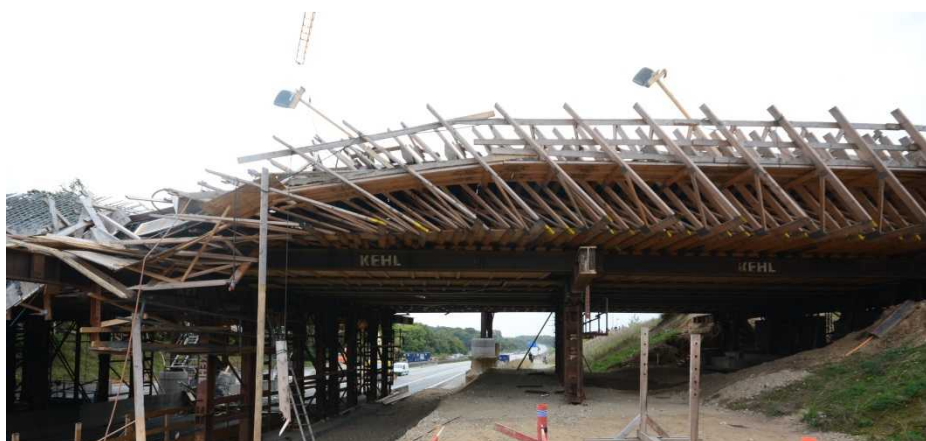
Figur 24 Den nordlige facade mellem girder 6 og 8
