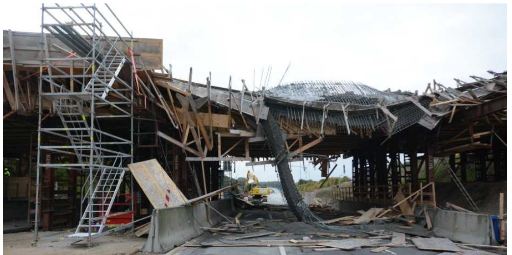
Figur 23 Den vestlige gennemkørselsåbning set fra nord mellem girder 5 og 6.
