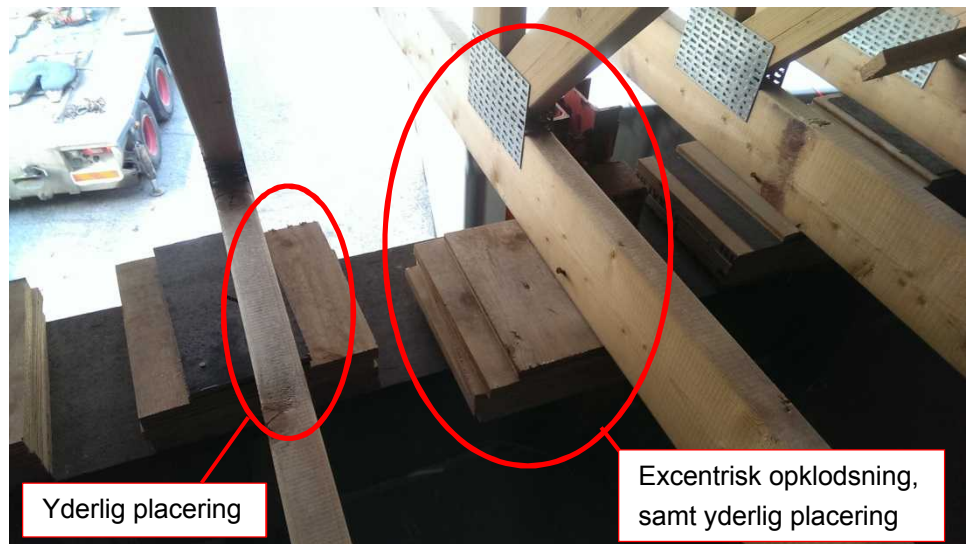
Figur 47. Excentriske og forskubbede oplodsninger, der er placeret yderligt.
