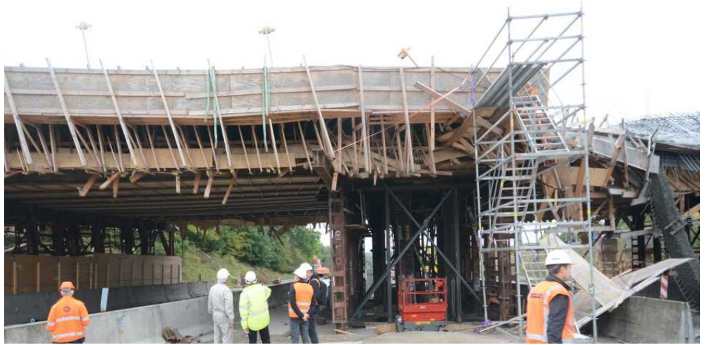
Figur 22 Midterrabbatten set fra nord mellem girder 4 og 5.
