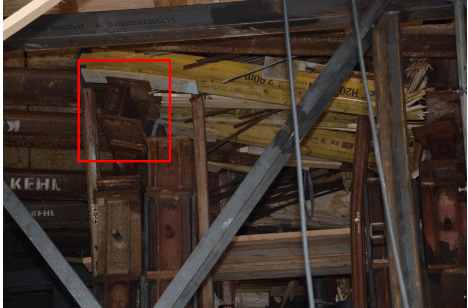
Figur 30. Tværdrager med begyndende kæntring.
