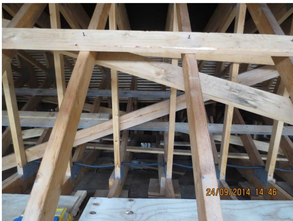
Figur 40. Foto af spærkonstruktionen, bemærk skråafstivninger og vandrette lægter er sømmet på hver sin side af gitterstænger.
