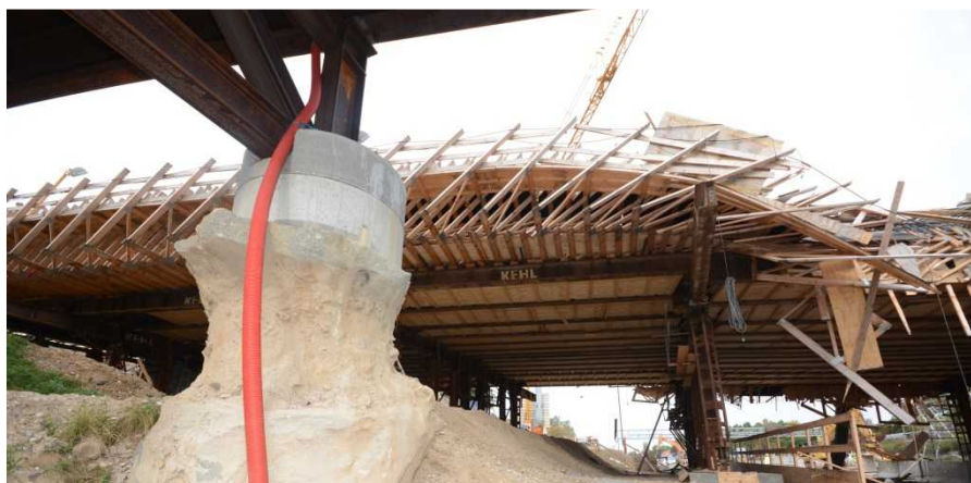
Figur 17. Facade mellem girder 6 og 8.
