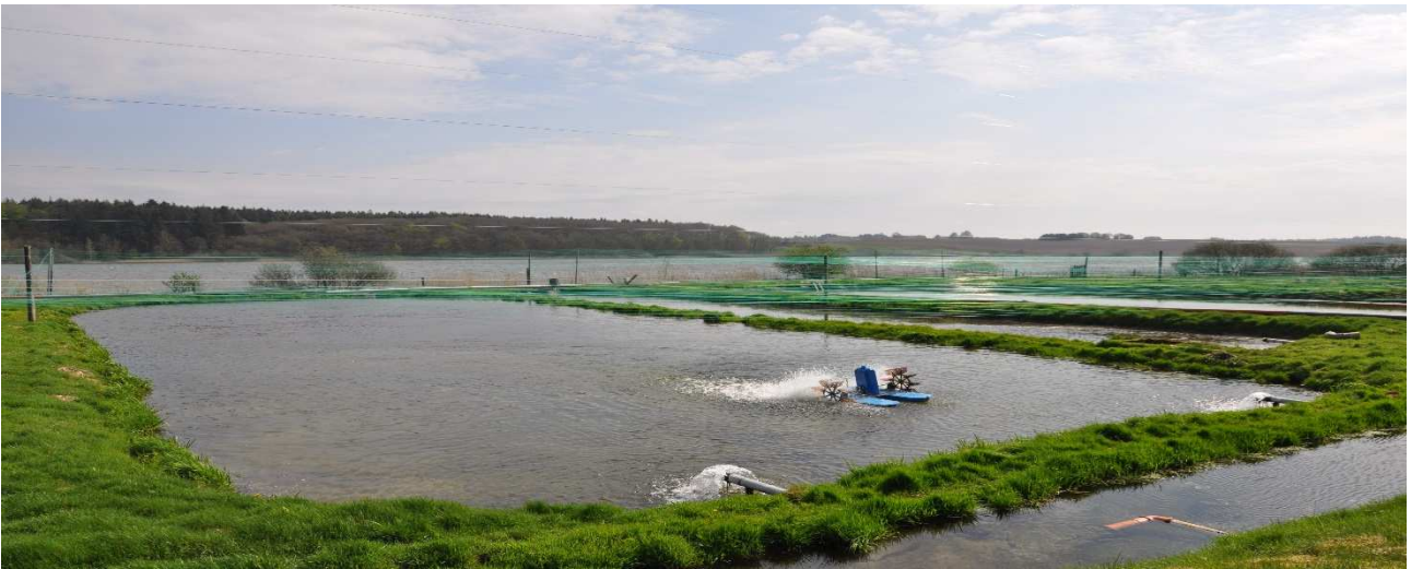
Hallesø Dambrug 2013 – økologisk fiskeopdrætsanlæg. Foto: Villy J. Larsen
