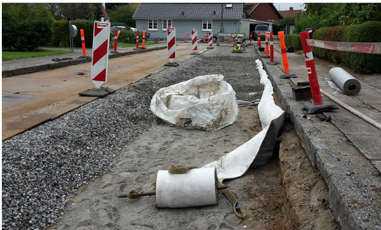
Under den "utætte" asfalt lægges drænstabil, hvorfra regnvandet kan nedsive. En betonitmåtte afgrænser bassinet mod kantstenen. Foto: Martin W. Sørensen
