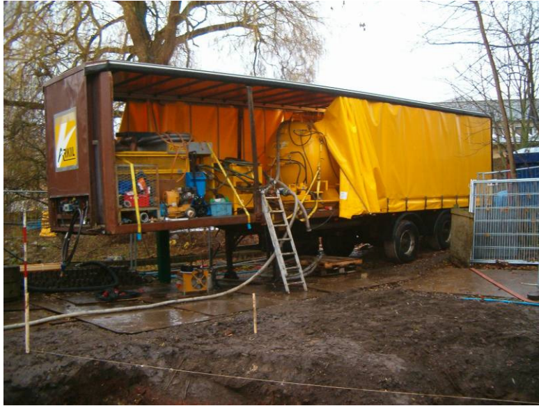
Figur 2.4 Opblanding af bentonit- slurry
