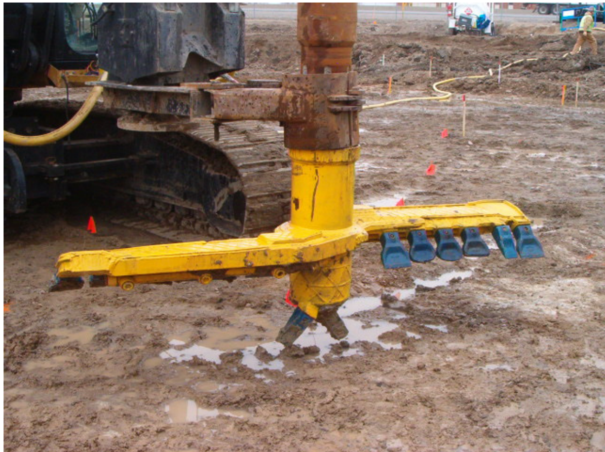
Figur 2.2 Soil-mixing udstyr ( Diameter = 1,5 m) – importeret fra USA.
