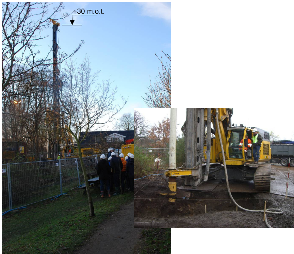
Figur 2.3 Anstilling af borerig med tilhørende hulsnegl, doseringslange for bentonitslurry m.v.
