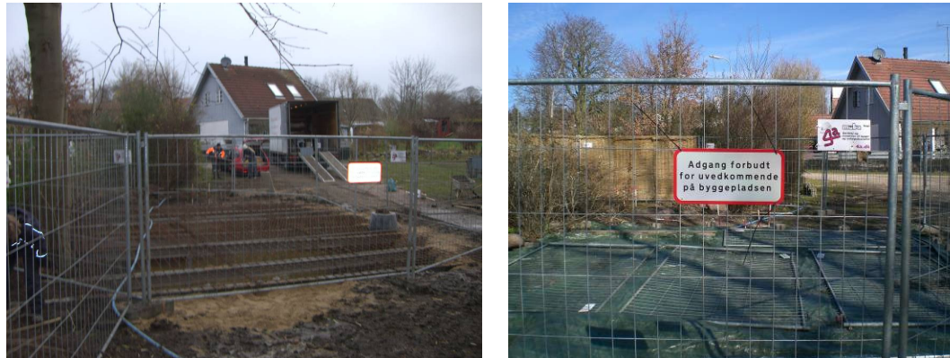
Figur 2.8 Afdækning af soil-mixing området før(tv.) henholdsvis efter(th.) udlægning af presenning.
