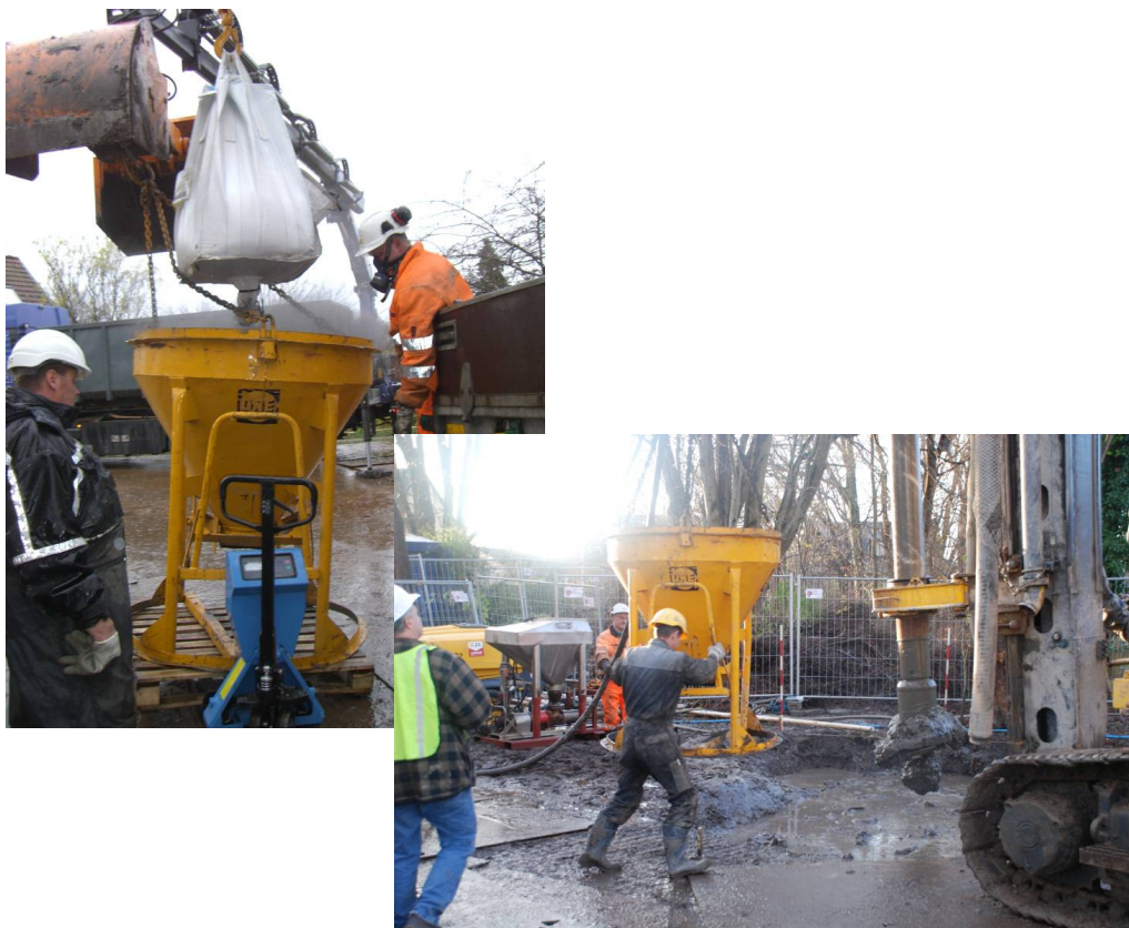
Figur 2.6 Trin 2 - Soil-mixing ved samtidig dosering af ZVI-jernpulver
