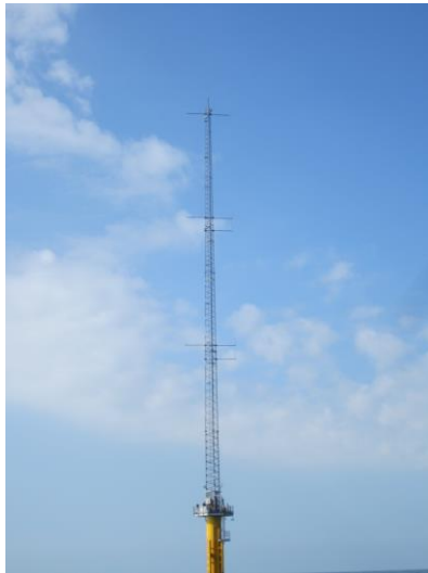
IEC compliant met mast
