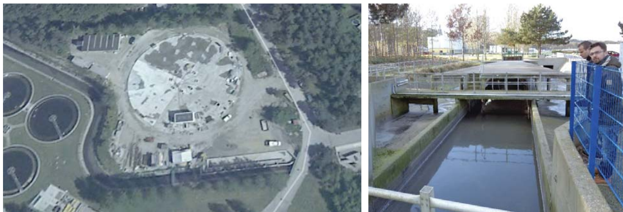
Figur 1 Overløbsbygværket ved Viby Renseanlæg med overløbskanal til sparebassinet.
