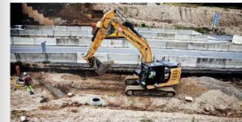
PÅ SIN GRÆBEM gravemaskinerne forer sig på Mørts Petersen se den digitale model, der viser, hvor han skal grave. Lærere i færdige avancer, hvis han er ved at komme ud fra grævmødet.
