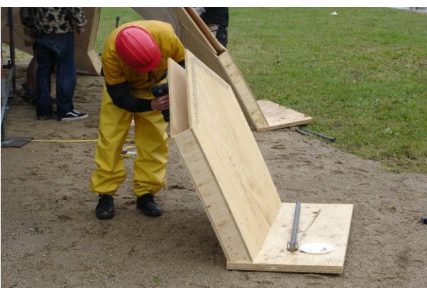
Fig. 20. Prefabricated edge element
