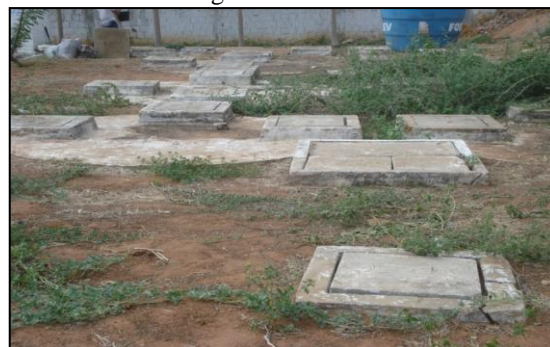
Figura 1 – ETE composta de um sistema de tanque séptico seguido de Filtro anaeróbio da FATEC – Cariri.
