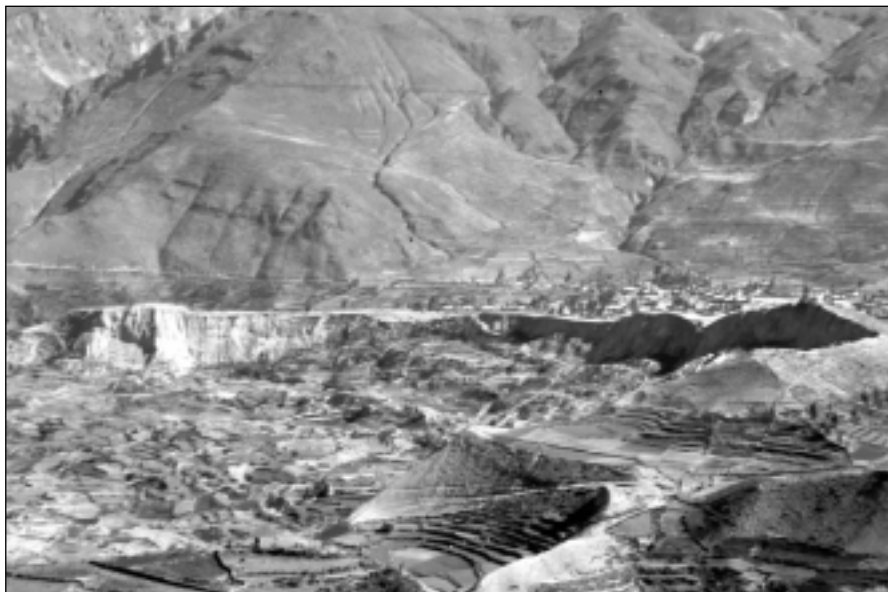
Figura 9. Deslizamiento antiguo en Madrigal (Perú). La superficie afectada es de 1,6 km 2 aproximadamente.
