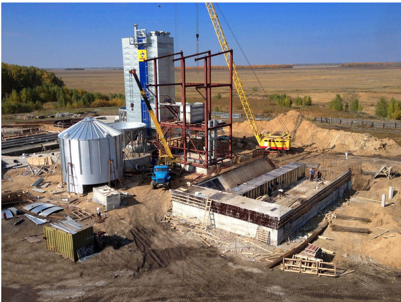
Рисунок 1 – Маслозавод «Алтайский подсолнечник»
