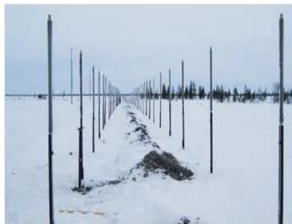
Нефтепровод «Ванкор–Пурпе», участок подземной прокладки
