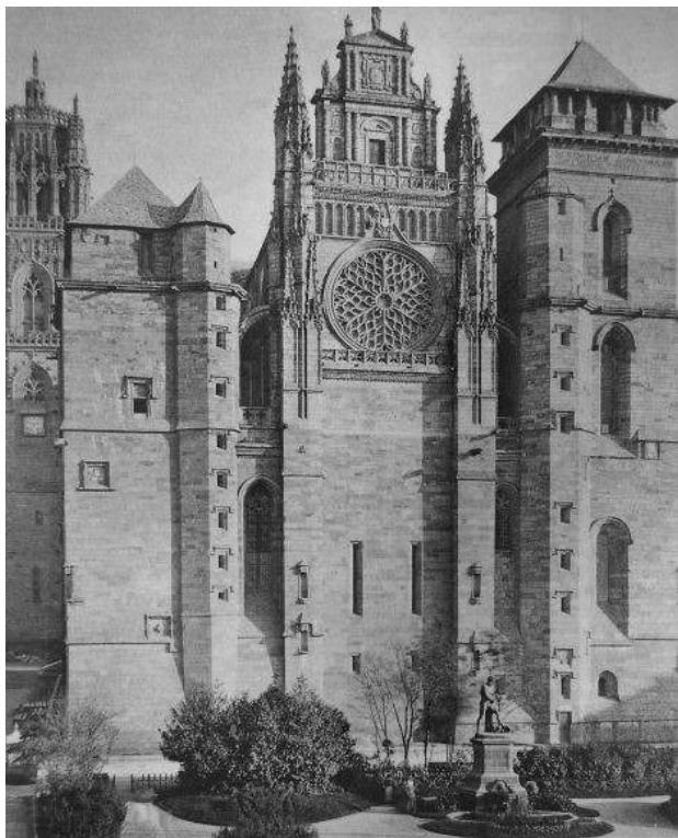
Fig. 2 Façade de la cathédrale de Rodez respectée par les architectes classiques (photo de l'auteur).
