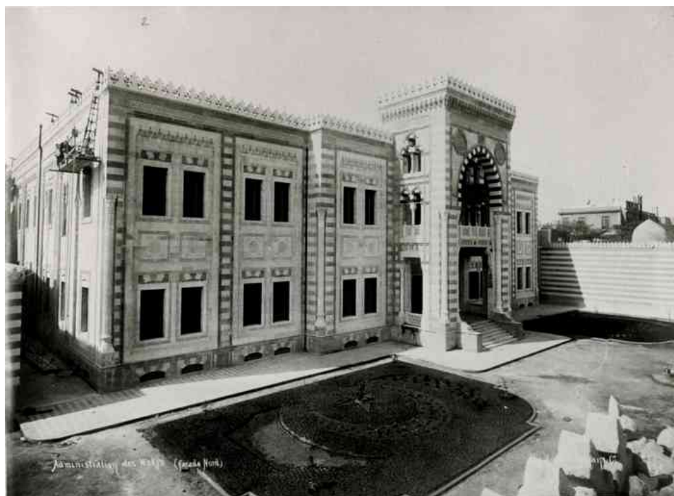
Figure 7 : Siège de l'Administration des Waqfs, Le Caire, 1899, Saber Sabri arch.
