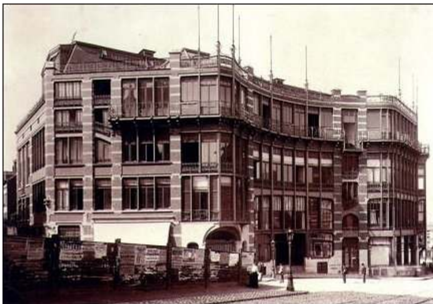
1899 (démolie en 1965), photographie, Bruxelles.
