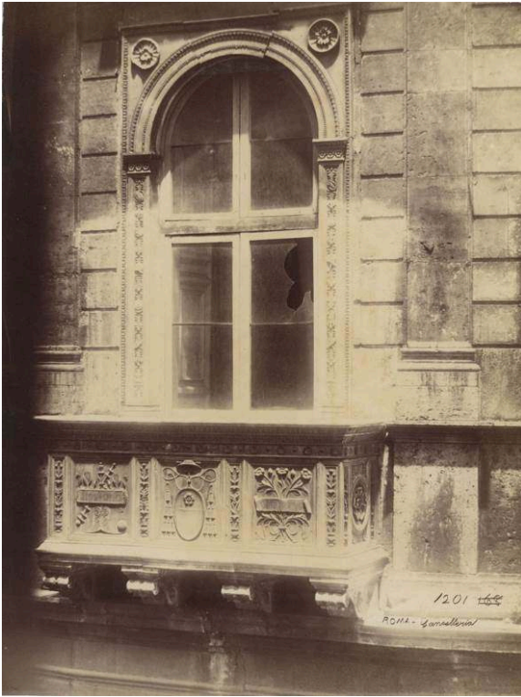
Fig. 5 : Gustave Chauffourier d'après un négatif d'Adriano De Bonis, Vue de la fenêtre d'angle du palais de la Chancellerie à Rome , tirage albuminé d'après négatif verre, 24,6 x 18,6 cm, Paris, collection particulière.
