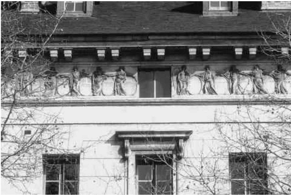
Fig. 13. Vue de la frise d'un pavillon de la Barrière de Denfert Rochereau à Paris
