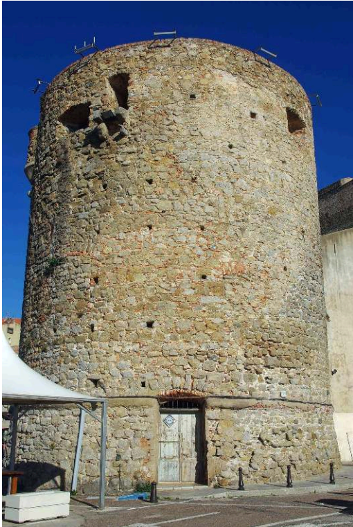
Fig. 2 – Vue générale de la tour du Sel depuis l'est
