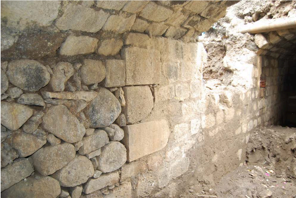
Fig. 5 – Vue du mur ouest
