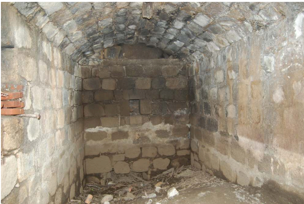
Fig. 4 – Vue de l'extrémité nord
