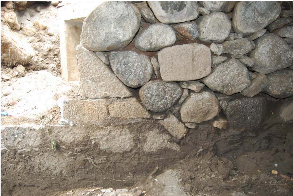
Fig. 6 – Vue du mur est
