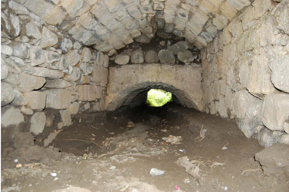
Fig. 3 – Vue de l'extrémité sud
