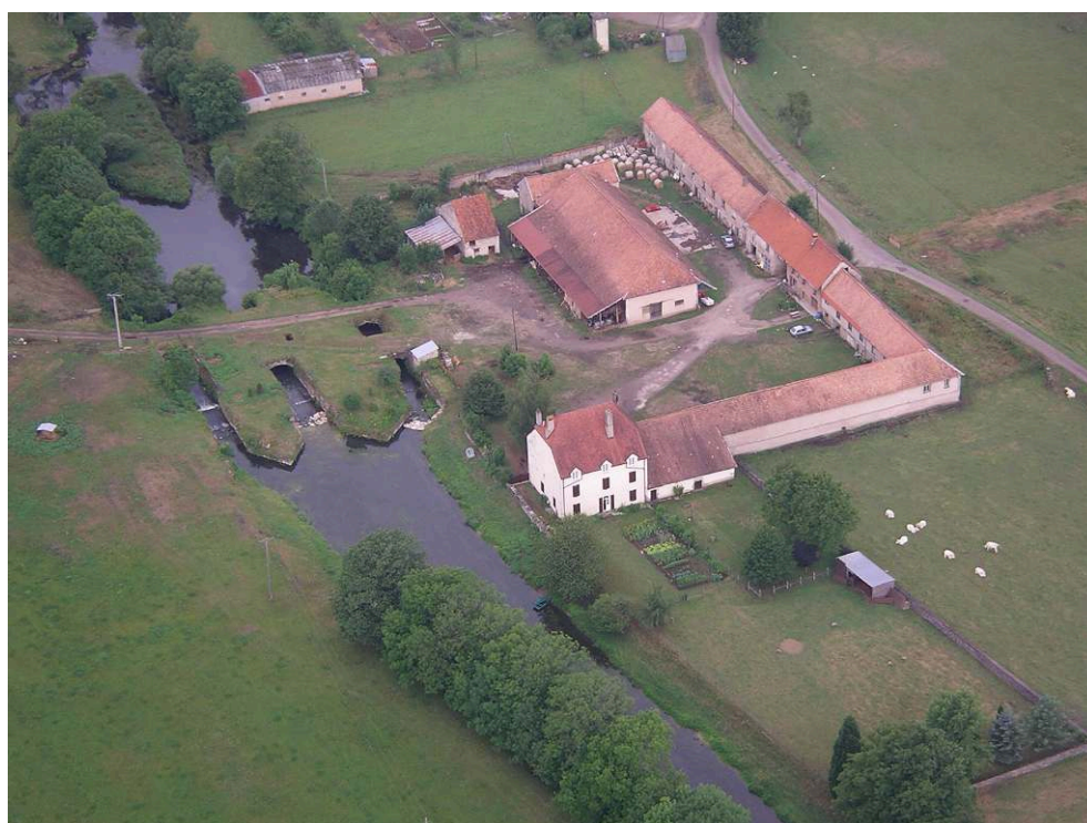
Fig. 2 – Vue aérienne générale de la forge en 2005
