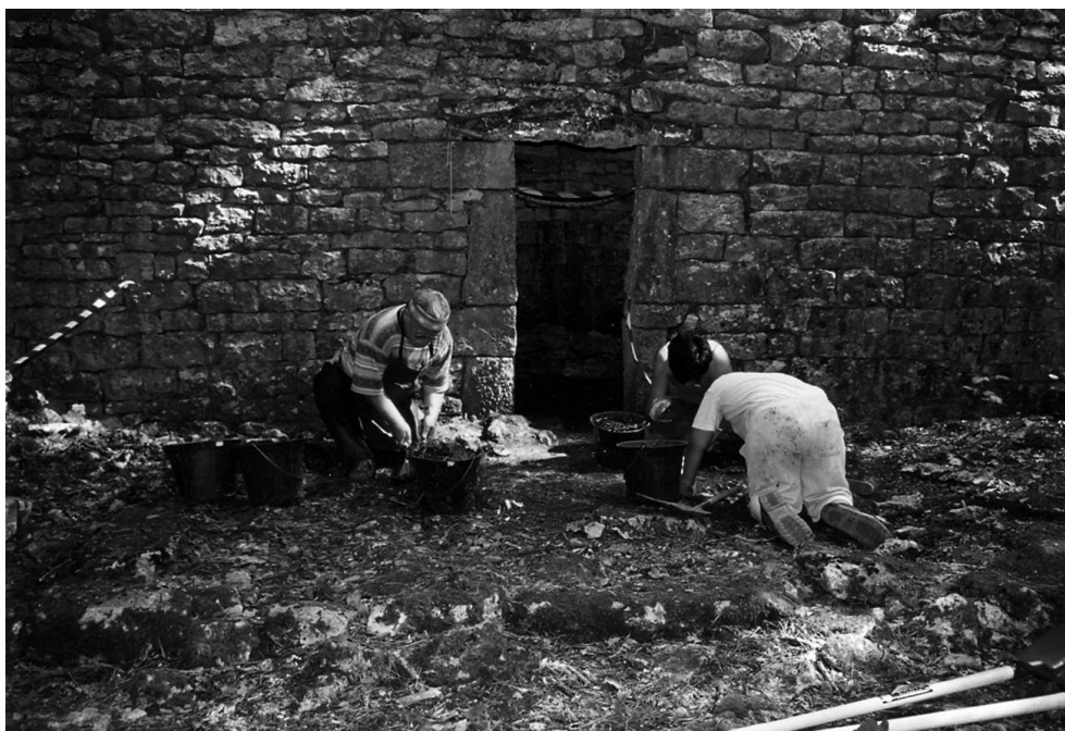
Fig. 1 – Dégagement de l'entrée d'un bâtiment
