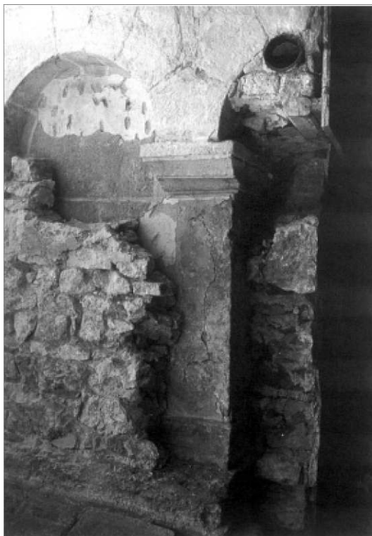
Fig. 2 – Baies romanes en cours de dégagement
