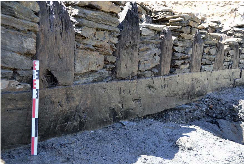
Fig. 3 – Détail du quai, vue du nord-est
