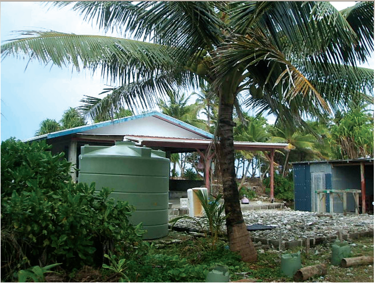
figure 8 : Citerne individuelle pour la collecte de l'eau de pluie (cliché : Y. Lageat, 2012).
