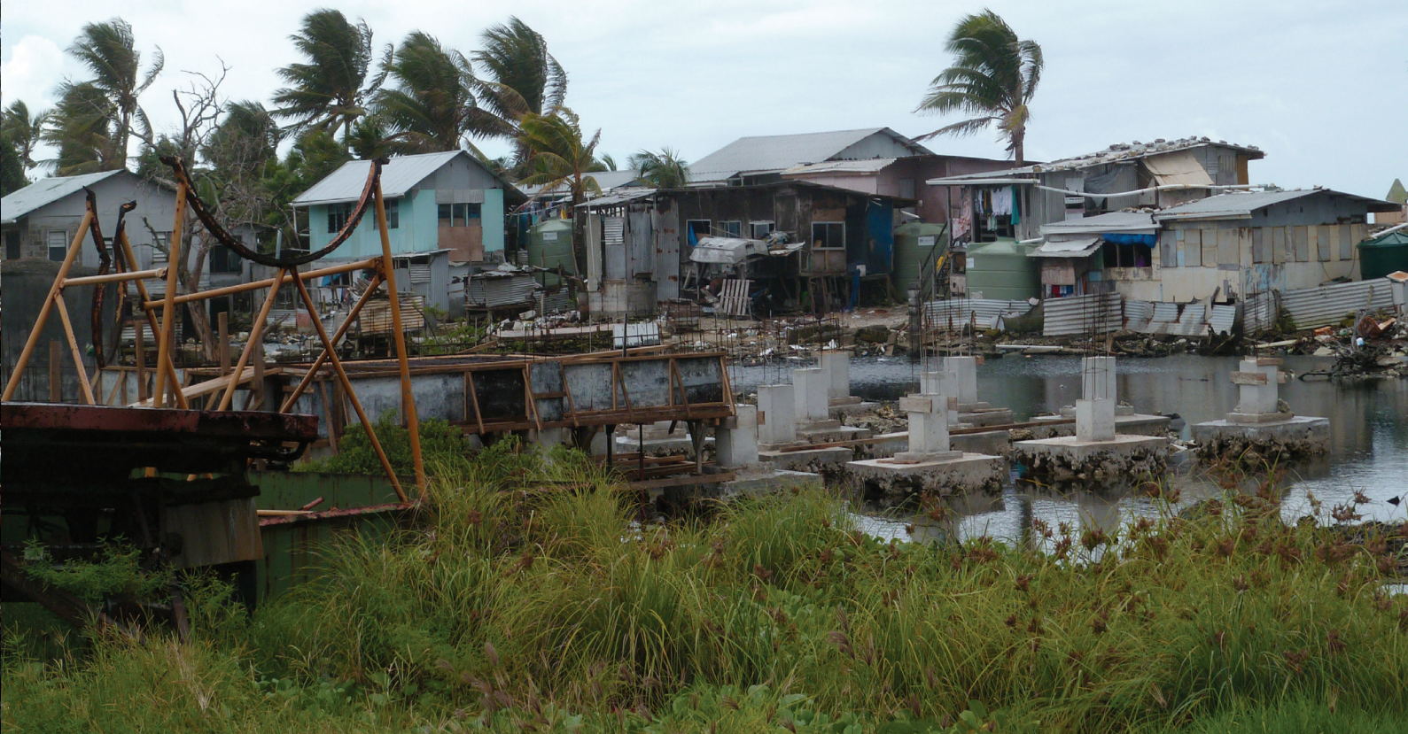
Implantation d'habitations : utilisation des anciens sites d'excavation - borrow pit, île de Fongafale, atoll de Funafuti (cliché : Y. Lageat).
