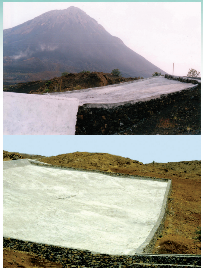
figure 8 : Exemples d'impluvium : A- dans la caldeira dominée par le volcan actif de Fogo (cliché de G. Marie), et B- dans le bas-pays aride (cliché de Y. Lageat).
