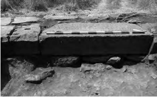
Fig. 18 : Seuil et premiers blocs du toichobate dans le sondage 2B dans le Portique Ouest (E. Le Quéré).
