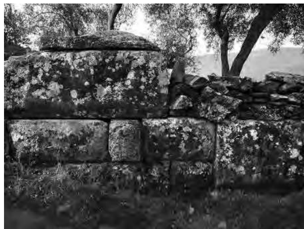
Fig. 24 : Mur dans le secteur de la tour semi-circulaire (BV).
