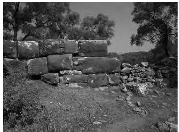
Fig. 31 : Porte secondaire au Nord de la tour semi-circulaire (BV).
