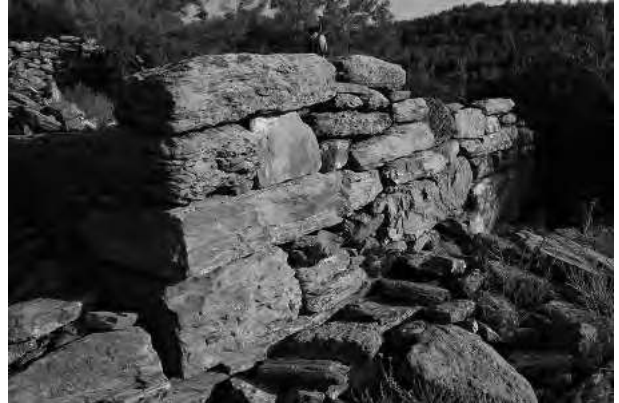
Fig. 41 : Angle S-E de la Tour Est (K. Konuk).
