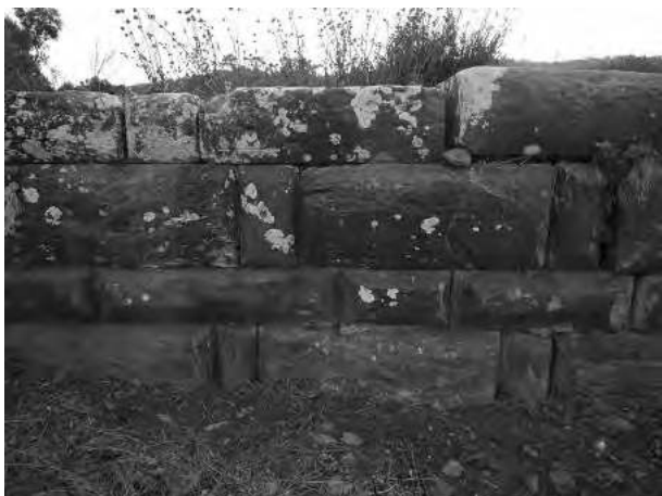
Fig. 23 : Tour carrée sud, détail (B. Vergnaud).
