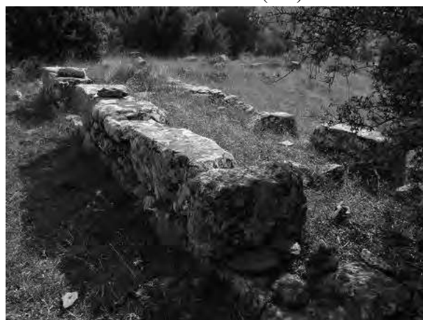
Fig. 26 : Mur dans le secteur nord (BV).
