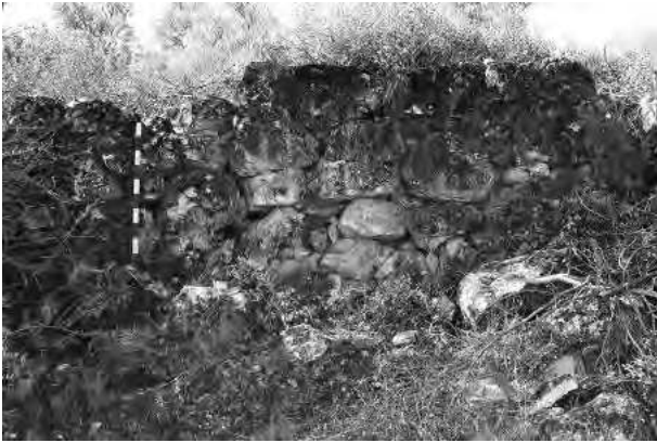
Fig. 76 : Tronçon ouest de la muraille du site de Kale Yıkı (K. Konuk).
