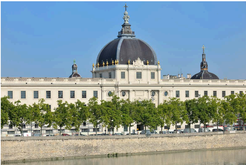
L'hôtel-Dieu depuis les berges du Rhône.
