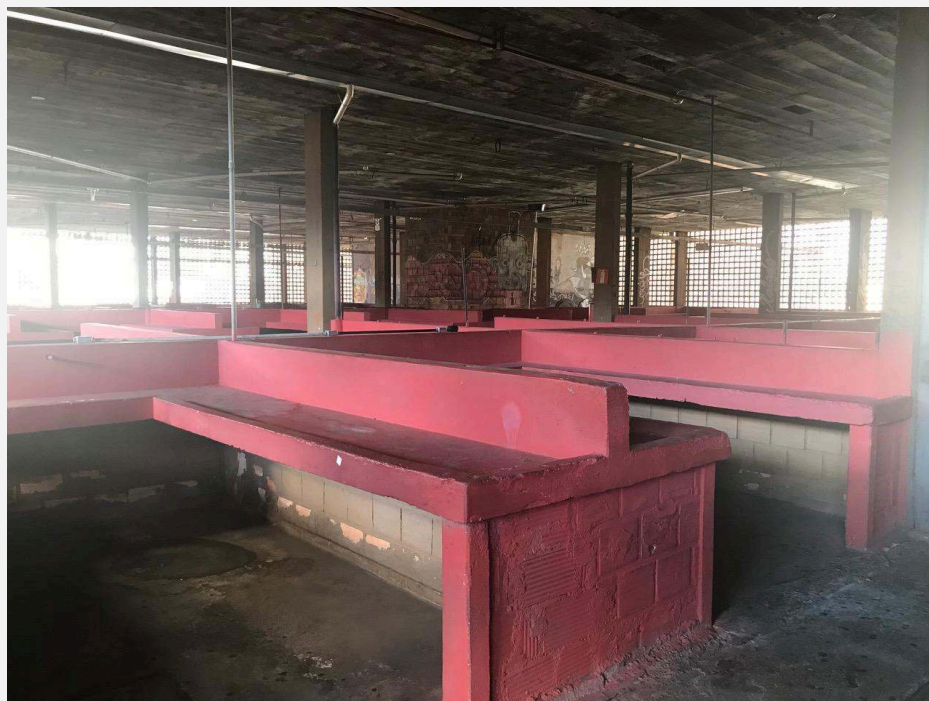
ESTRUTURAS DO TERCEIRO ANDAR.
